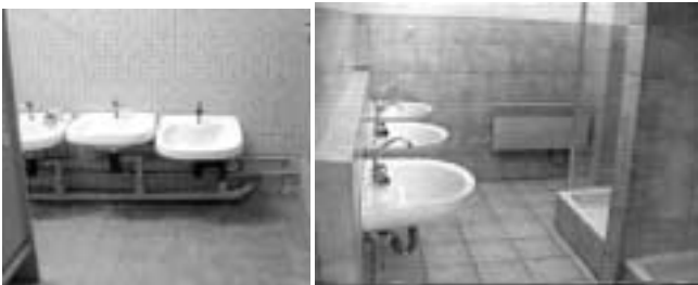
Waschraum vorher nachher
